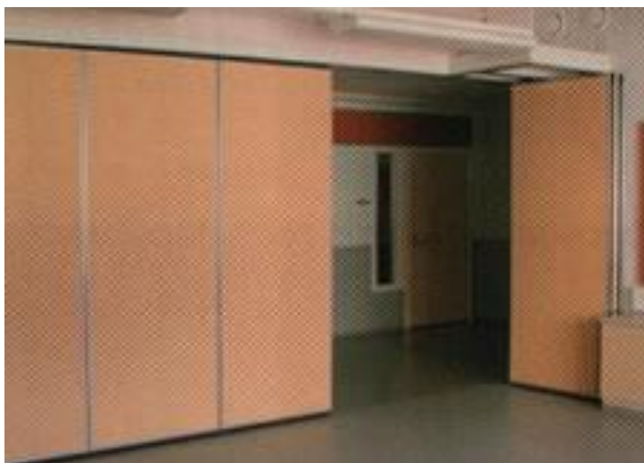
Przykładowe rozwiązanie systemowej ściany działowej z drzwiami zamocowanymi w elemencie panelu.
